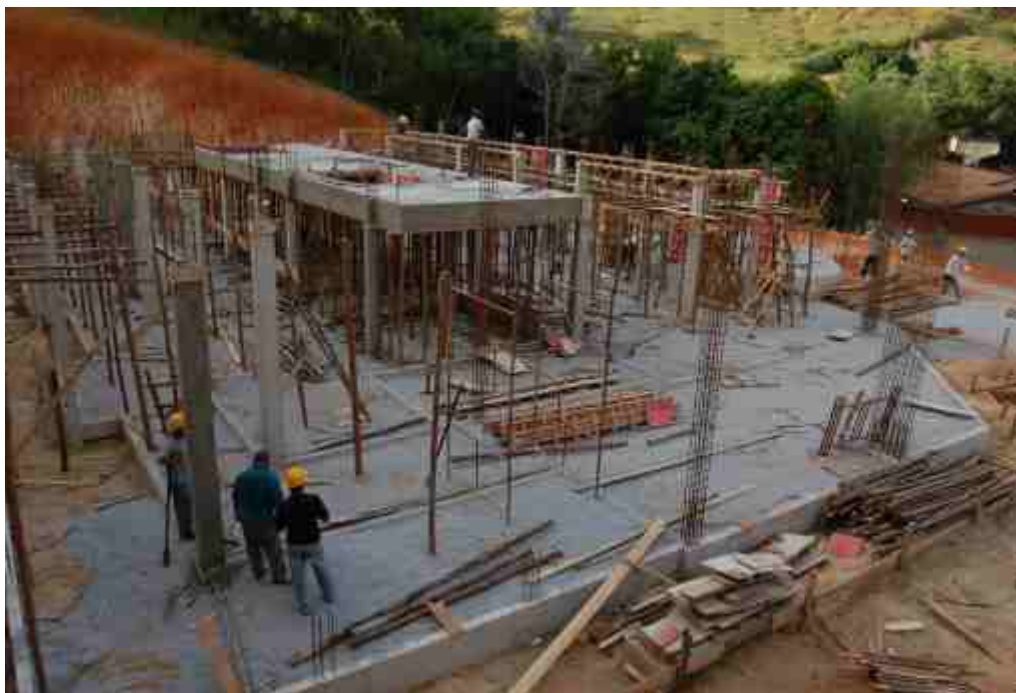
Construção da USF de Santa Terezinha
